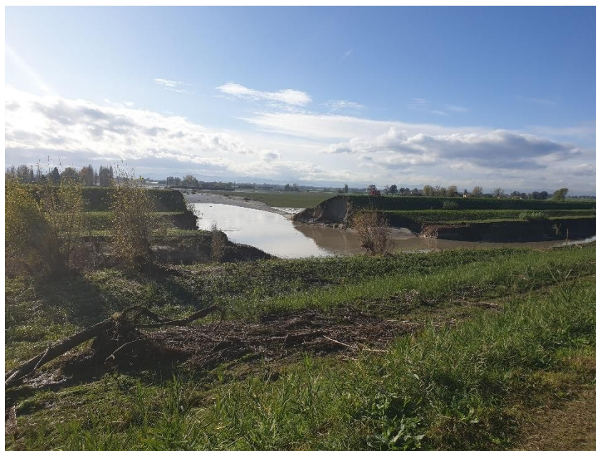
Cedimento arginale sul torrente Idice
