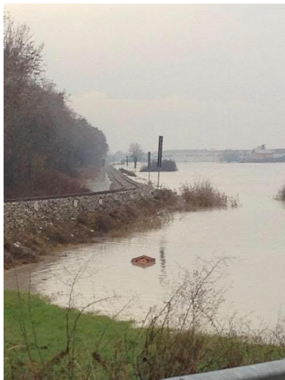
Termine tratto danneggiato (12.12.2017)
