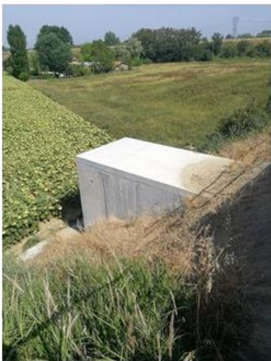
Ricostruzione rilevato e opere di drenaggio
