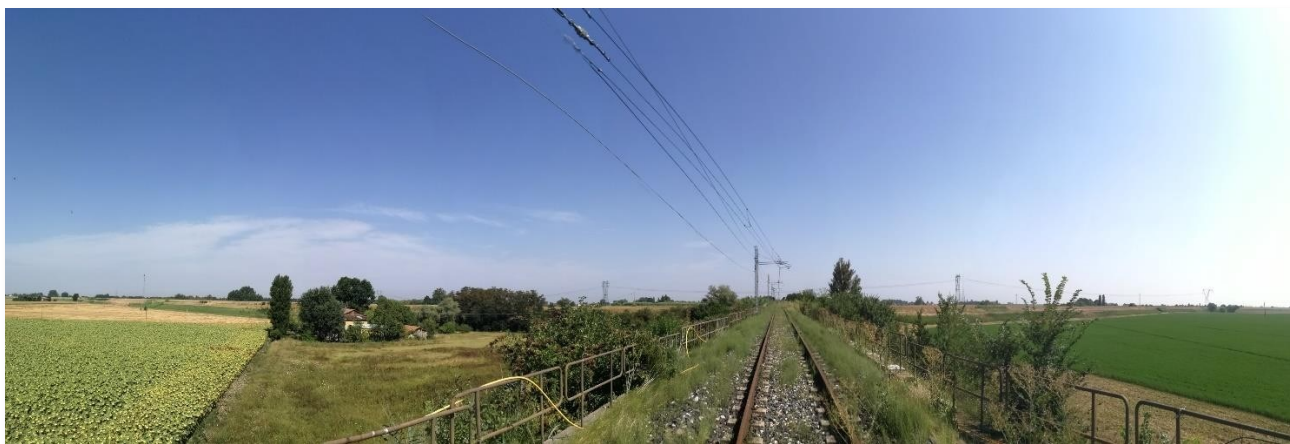
Rampa del ponte sul t. Idice – vista in direzione Mezzolara
