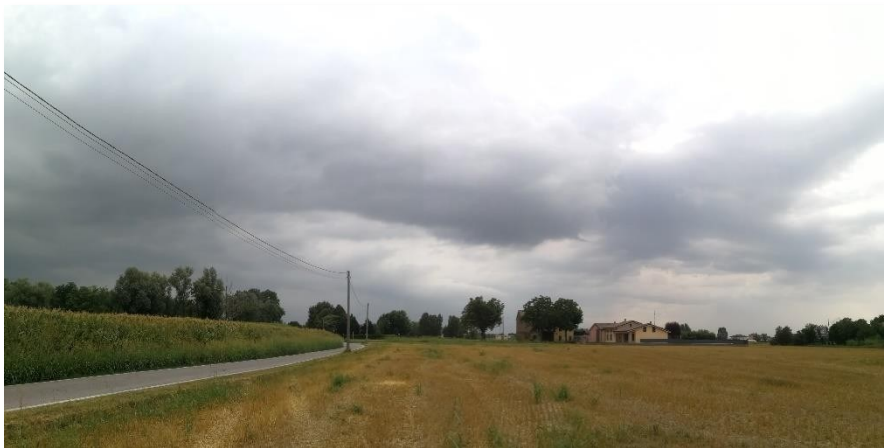
Argine destro del Fiume Enza in prossimità del tratto collassato
