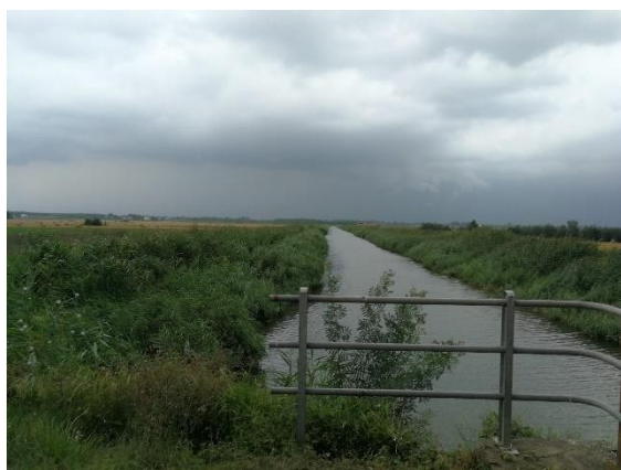
Termine tratta ripristinata – intersezione con il Canalazzo di Brescello
